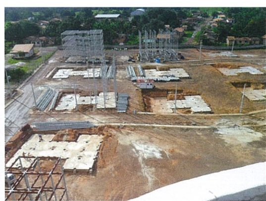
Ao lado, a estrutura metálica é conformada por perfis tubulares de seção quadrada e por vigas de perfis U enrijecidos, ambos formados a frio. Acima, perfis dos pilares são conectados à estrutura por meio de chumbadores
