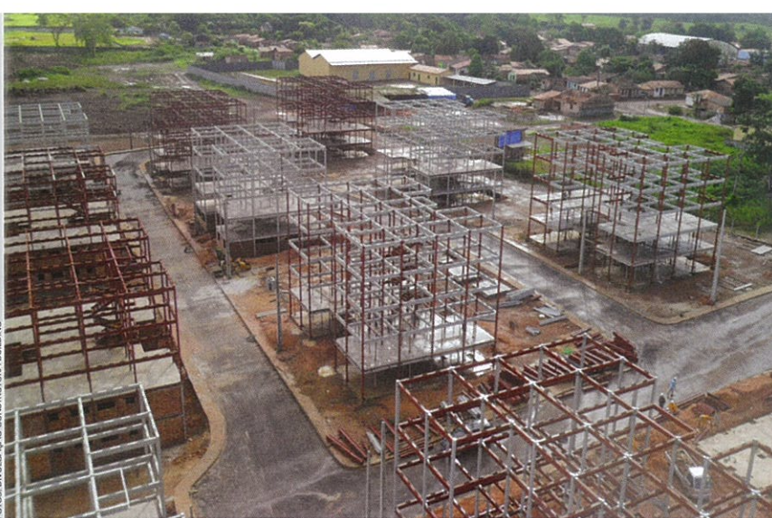
Ao lado, a estrutura metálica é conformada por perfis tubulares de seção quadrada e por vigas de perfis U enrijecidos, ambos formados a frio. Acima, perfis dos pilares são conectados à estrutura por meio de chumbadores
